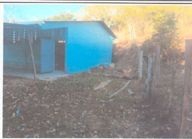
Foto 2: Mejoramiento cerco muro perimetral.
