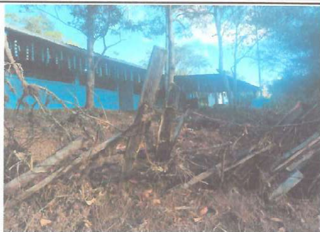
Foto 1: Mejoramiento cerco muro perimetral.
